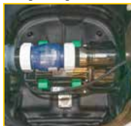
Rückschlagventil und Schmutzwasserpumpe Mach II
